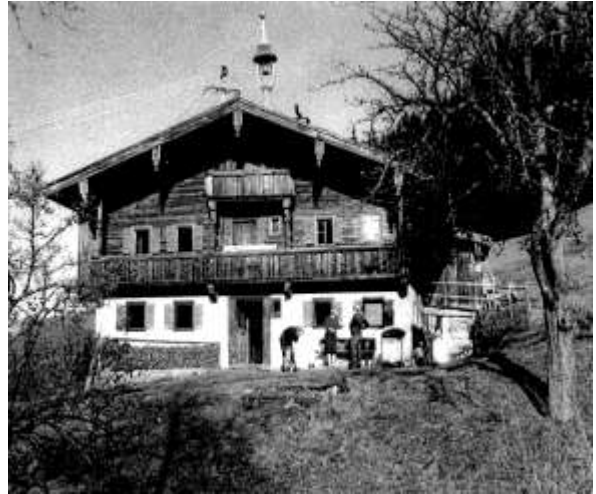
Das alte Bauernhaus Brennt vor dem Brand 1996. Auf der Firstpfette war die Jahreszahl 1727 eingekerbt.
