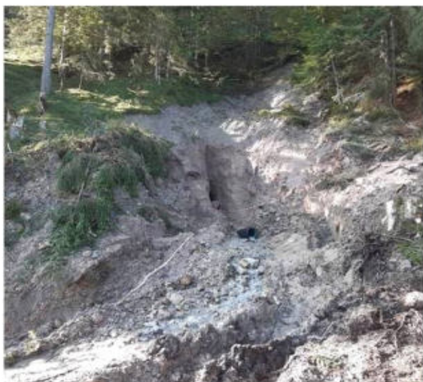
Rechts: Blick in den seit über 300 Jahren verschütteten und abgesoffenen Felixstollen
