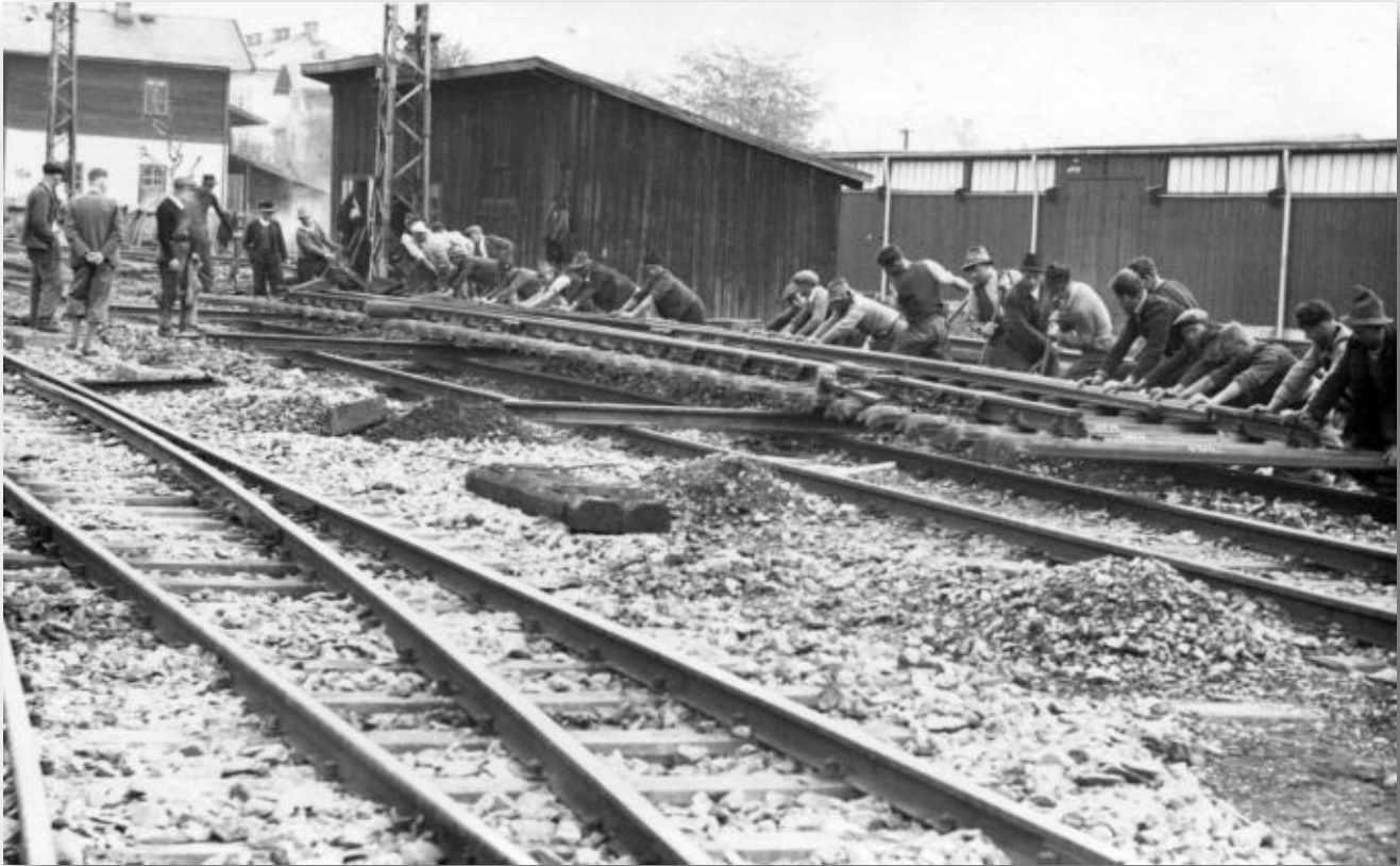
Maschinen standen kaum zur Verfügung, es galt händisch anzupacken, Schienenverlegung in Hochfilzen
