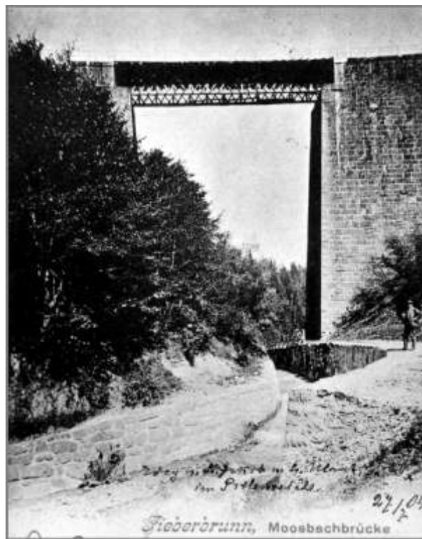
Die Moosbachbrücke vor dem Bau des zweiten Gleises 1912-1915 (Ansichtskarte, Hans-Jakob Schroll)
