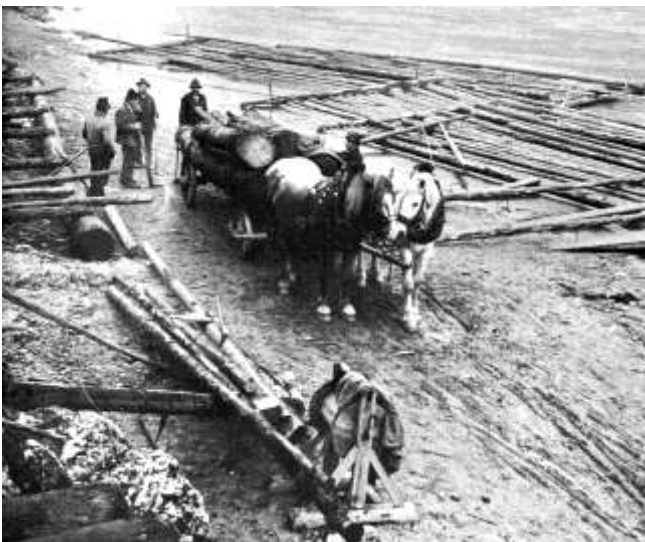
Zusammenstellung eines Bauholzfloßes
