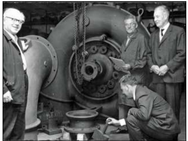
1953 - Einbau einer Turbine, rechts Johann Dandler
