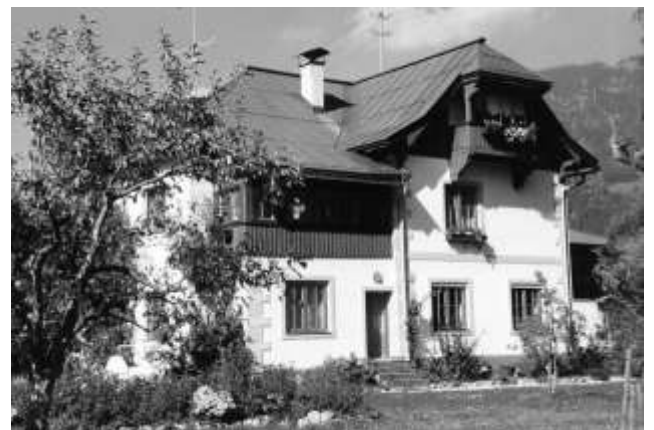
Nach dem Umbau 1986
